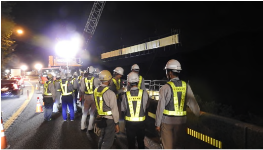
夜間架設の様子
